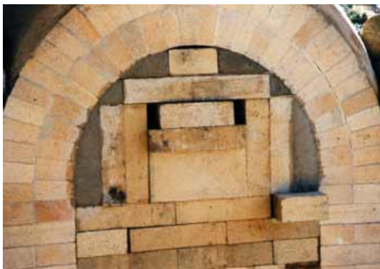
Hình 2a. S? d?ng v?t li?u ch?u l? a cho vòm lò (BEE, 2005)
